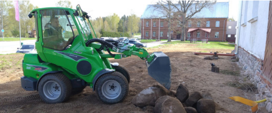
Sademevee eemale juhtimine kirikuhoonest, mis eelmisel aastal sai korraldatud, on juba avaldanud positiivset mõju kiriku kivimüüridele: seinad on kuivanud ning krohviparandused on jäänud pidama.
