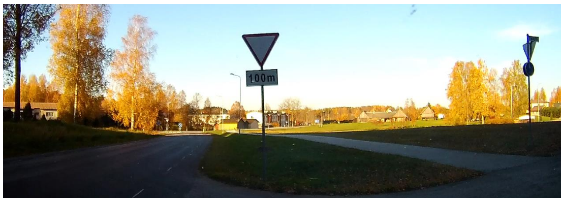
Foto 2.1. Vaade asukohale 3 Rõuge - Vastse-Roosa teelt
